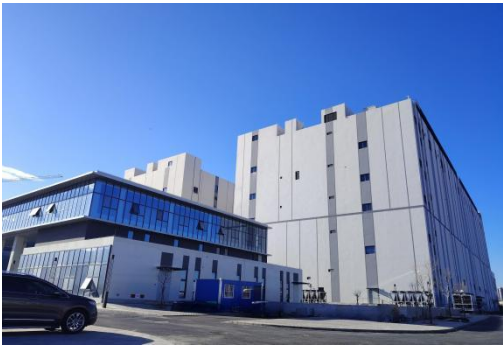
张家口世纪互联数据机房项目
