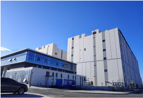
VNET Data Center
